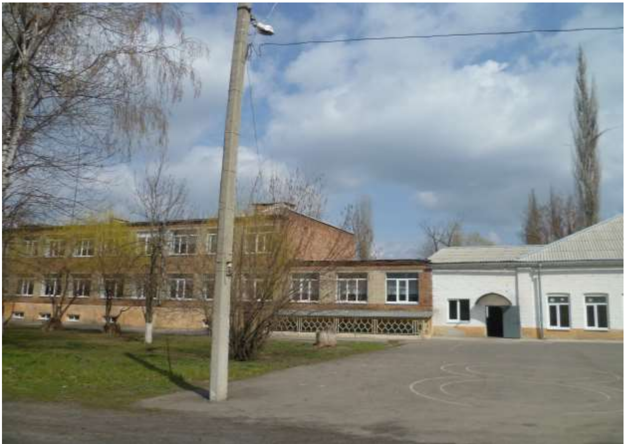
Фото 3 Площадка перед входом внутри двора
